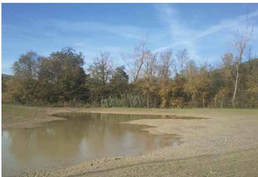
Figura 5.1.3 Tratto del fosso con evidente ristagno idrico derivante dal ruscellamento superficiale delle acque provenienti dal versante, spesso causa dell'intasamento del fosso e quindi di fenomeni di esondazione
